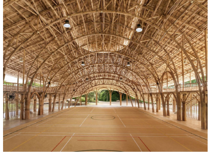
Gymnase en bambou de l'école Panyaden, architectes Chiangmai Life, Markus Roselieb et Tosapon Sittiwong, Thaïlande
