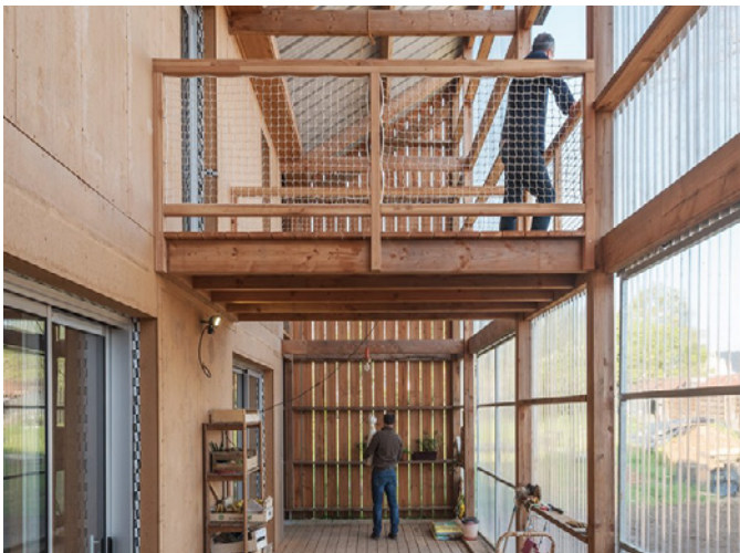
Maison en ossature bois et briques de terre crue, architectes Belanfand-Daubas, Nozay.
