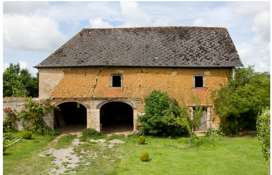
Bâtiment en bauge, Manche
