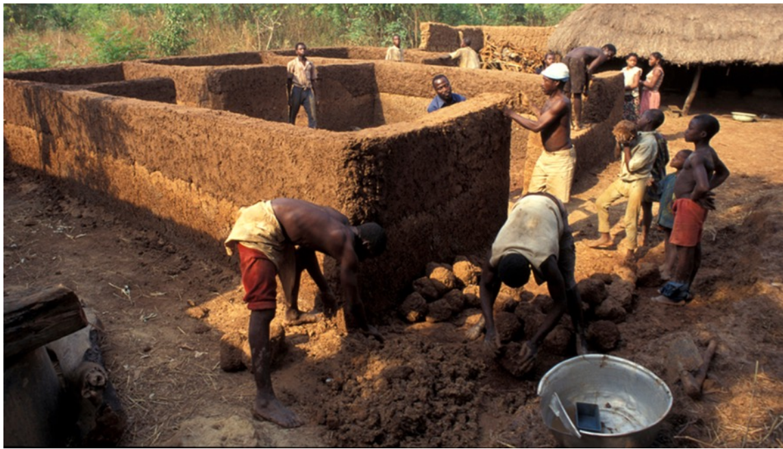
Construction en terre, murs en bauge
