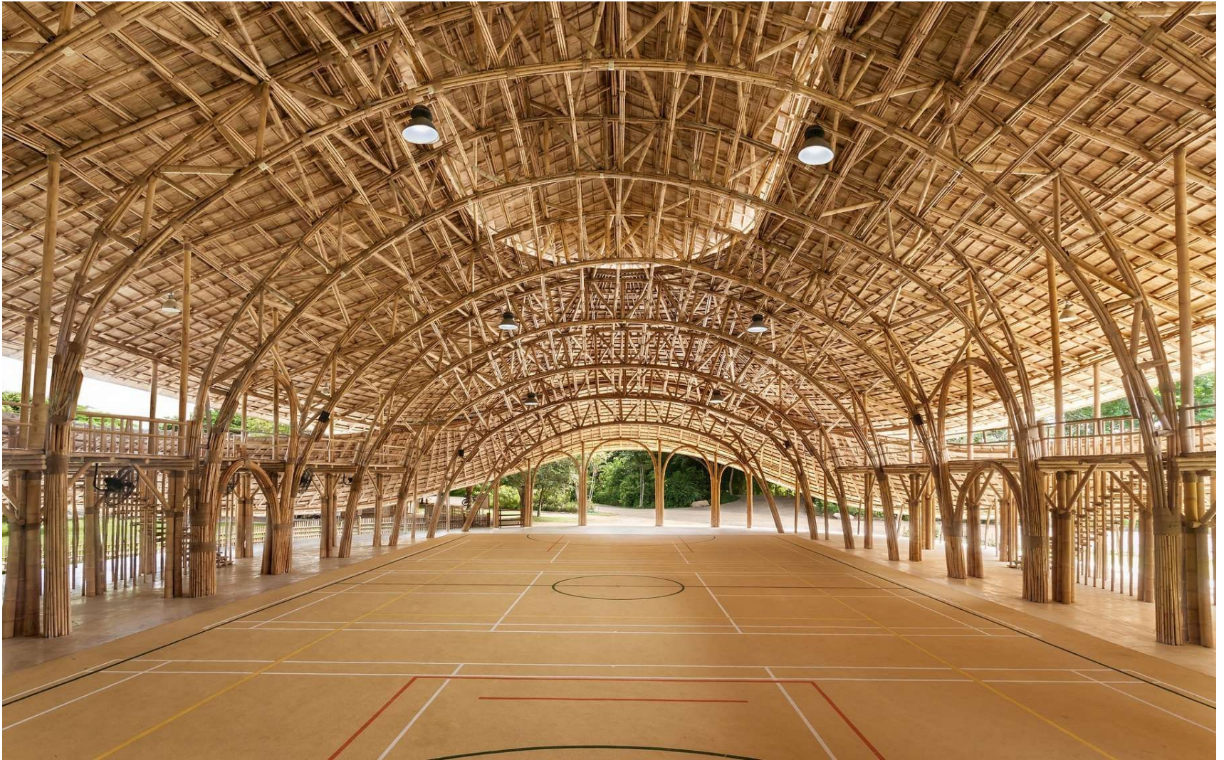
Gymnase de l'école internationale Panyaden par les architectes Chiangmai Life, Markus Roselieb et Tosapon Sittiwong, Thaïlande • bambou
