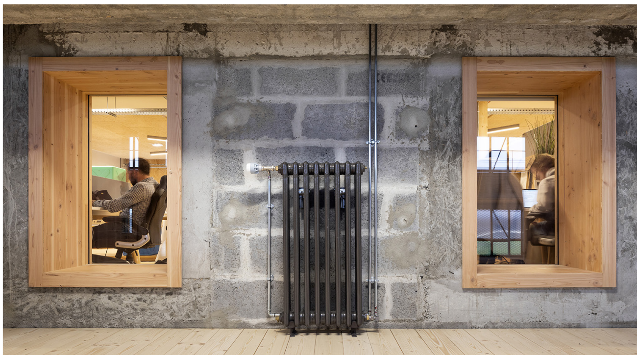
Réemploi de radiateurs en fonte au Wip à Colombelles - photo : Cyrus Cornut
